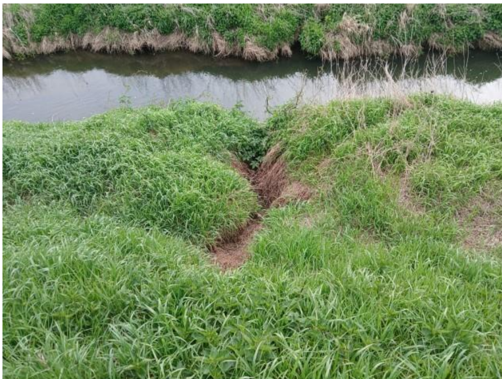
Foto 6: Břeh a hráz poškozené bobrem z návodní strany (PB: ř. km 16,440).
