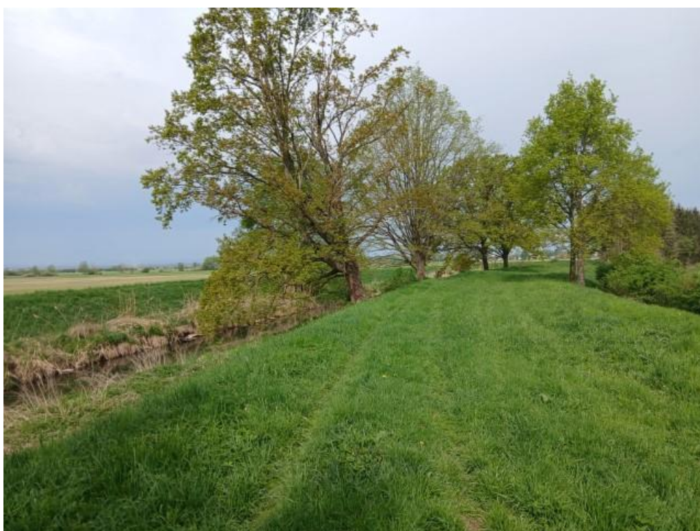
Foto 10: Začátek levobřežní hráze je rozšířen přísypem. Na návodním líci OH je několik dubů.
