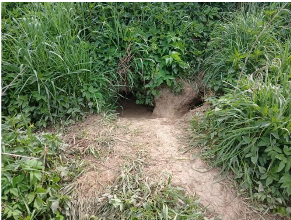
Foto 7: Hráz poškozená bobrem ze vzdušné strany v místě zabetonovaného stavidlového objektu (PB: ř. km 15,800). Předpokládáme, že nora vede skrz celou hráz.
