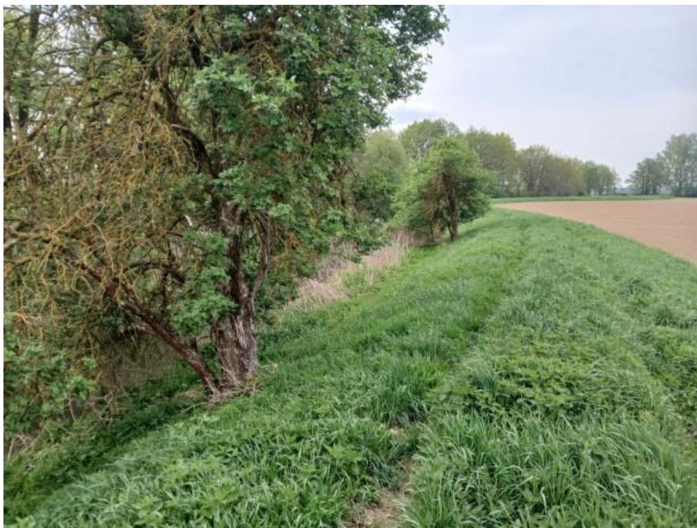
Foto 1: Náletové dřeviny na návodním líci a vyjeté koleje v koruně OH (PB: ř. km 17,300 po vodě).
