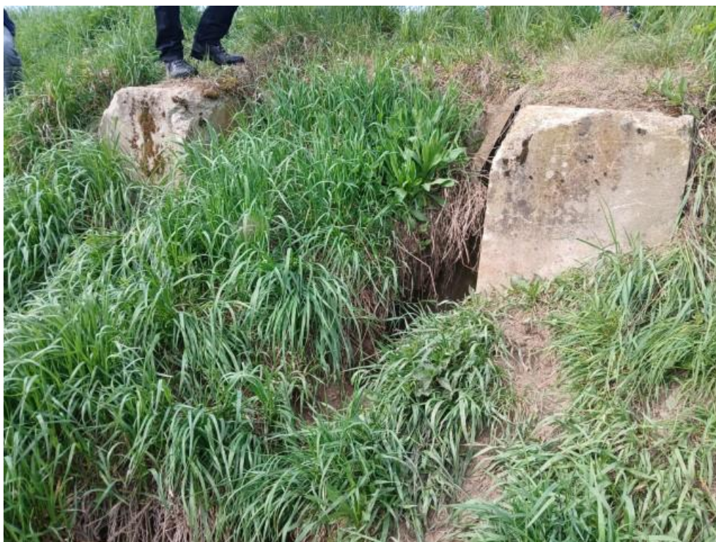
Foto 6: Hráz poškozená bobrem z návodní strany v místě zabetonovaného stavidlového objektu (PB: ř. km 15,800). Předpokládáme, že nora vede skrz celou hráz.
