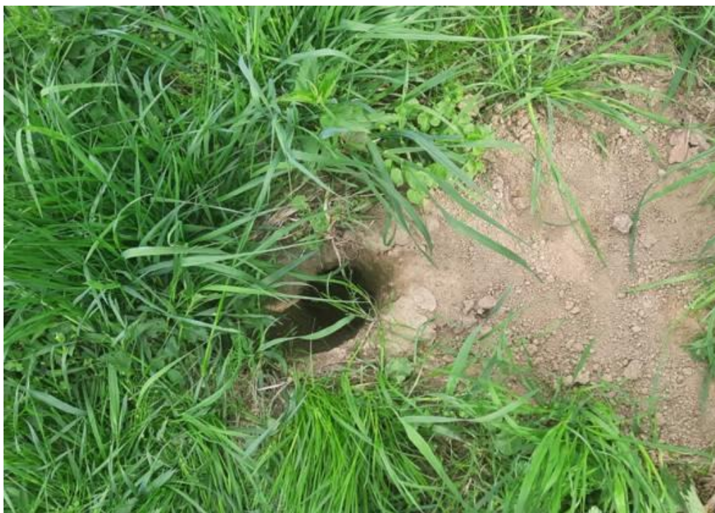
Foto 2: Průduch z bobří nory na korunu hráze (PB: ř. km 17,150).
